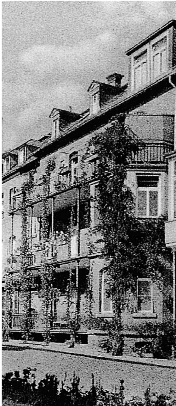
Stammhaus in der Platter Straße
