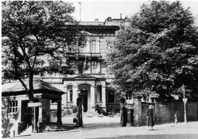
Eingang zu den Städtischen Krankenanstalten an der Schwalbacher Straße
